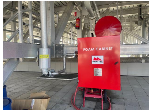
Figur 9: Nylig installert skap med påkobling til stigerør og skum, både ved og under helidekket (bilder er tilsendt fra leder for plasstjenesten Bergen helikopterlandingsplass).
