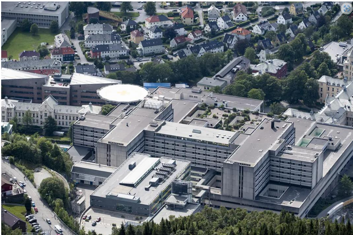
Figur 3: Oversiktsbilde over Haukeland Universitetssykehus.
