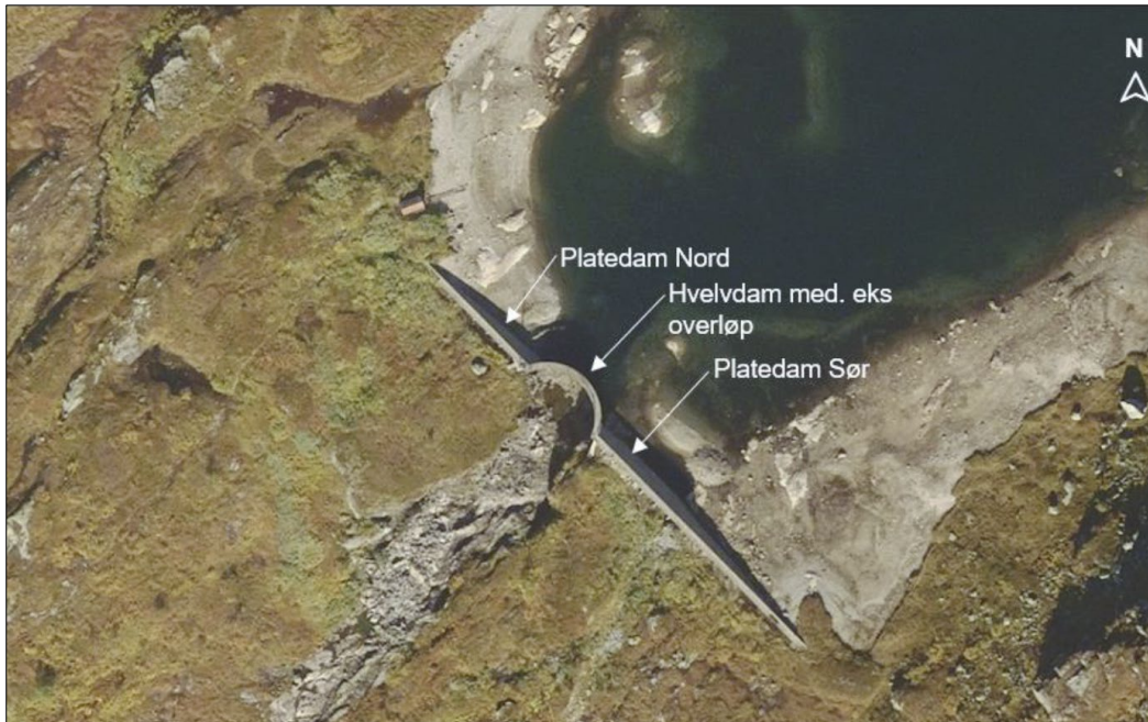
Figur 1. Dam Norddalsvatn før rehabilitering. Nedtappet.
