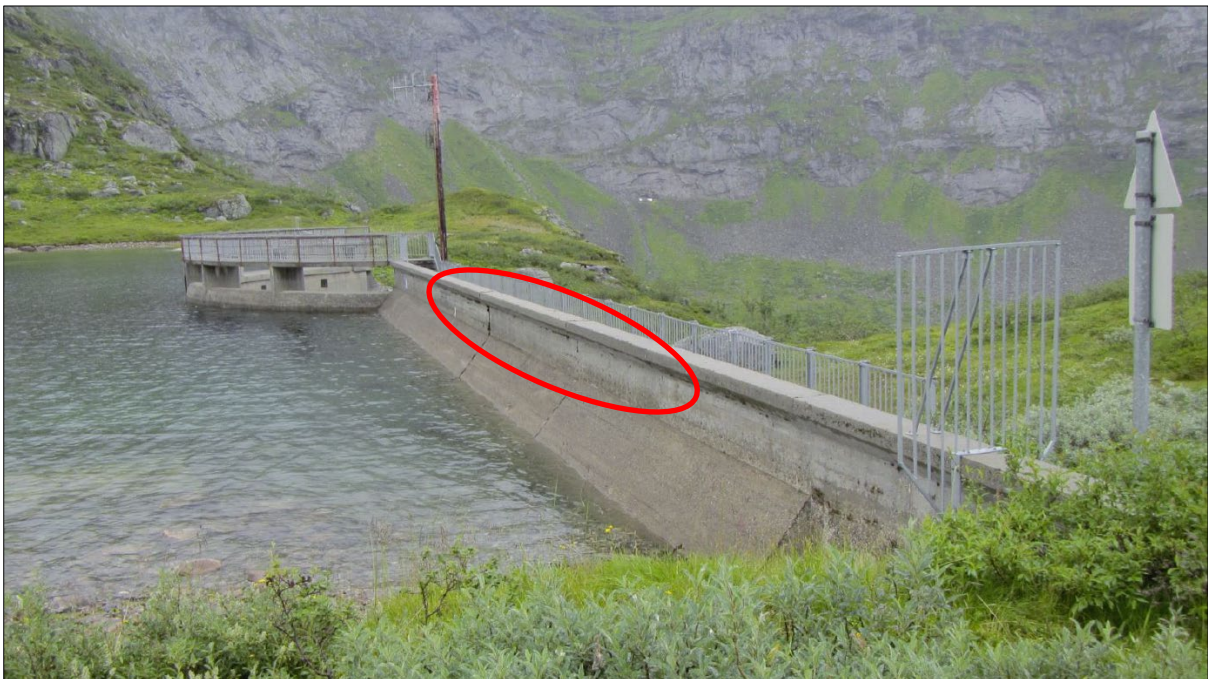
Figur 6. Ombygging av 3 platefelt til overløp.
