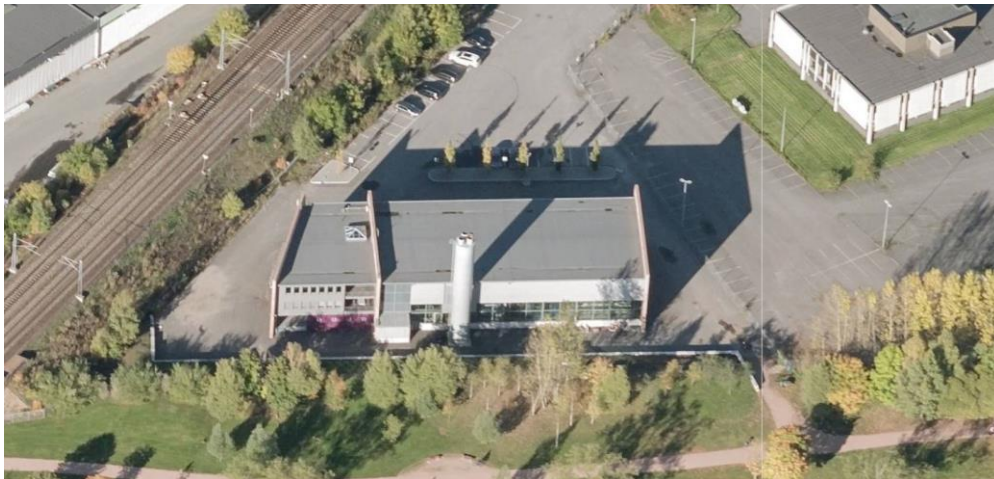
Figur 6-123: Drammen fjernvarmes eksisterende bygg
