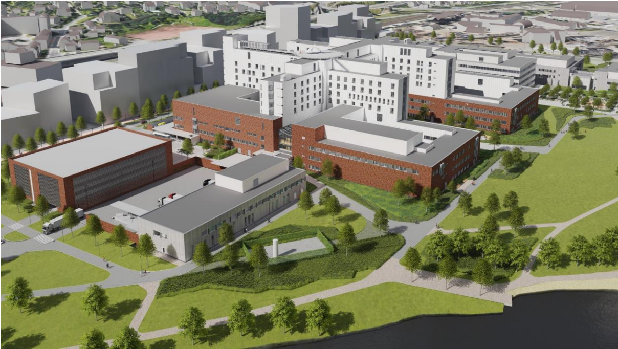
Figur 6-36: Illustrasjon av planlagt sengebygg sett fra sørvest, med det vestre poliklinikkbygget i forgrunnen (Ill.: Link arkitektur)
