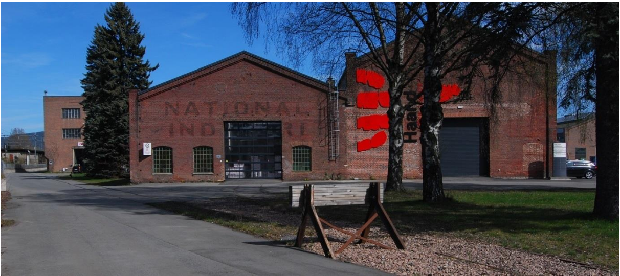
Figur 6-109: «Maskinhallen» sett fra sørvest (huser nå mikrobryggeriet HaandBryggeriet).
