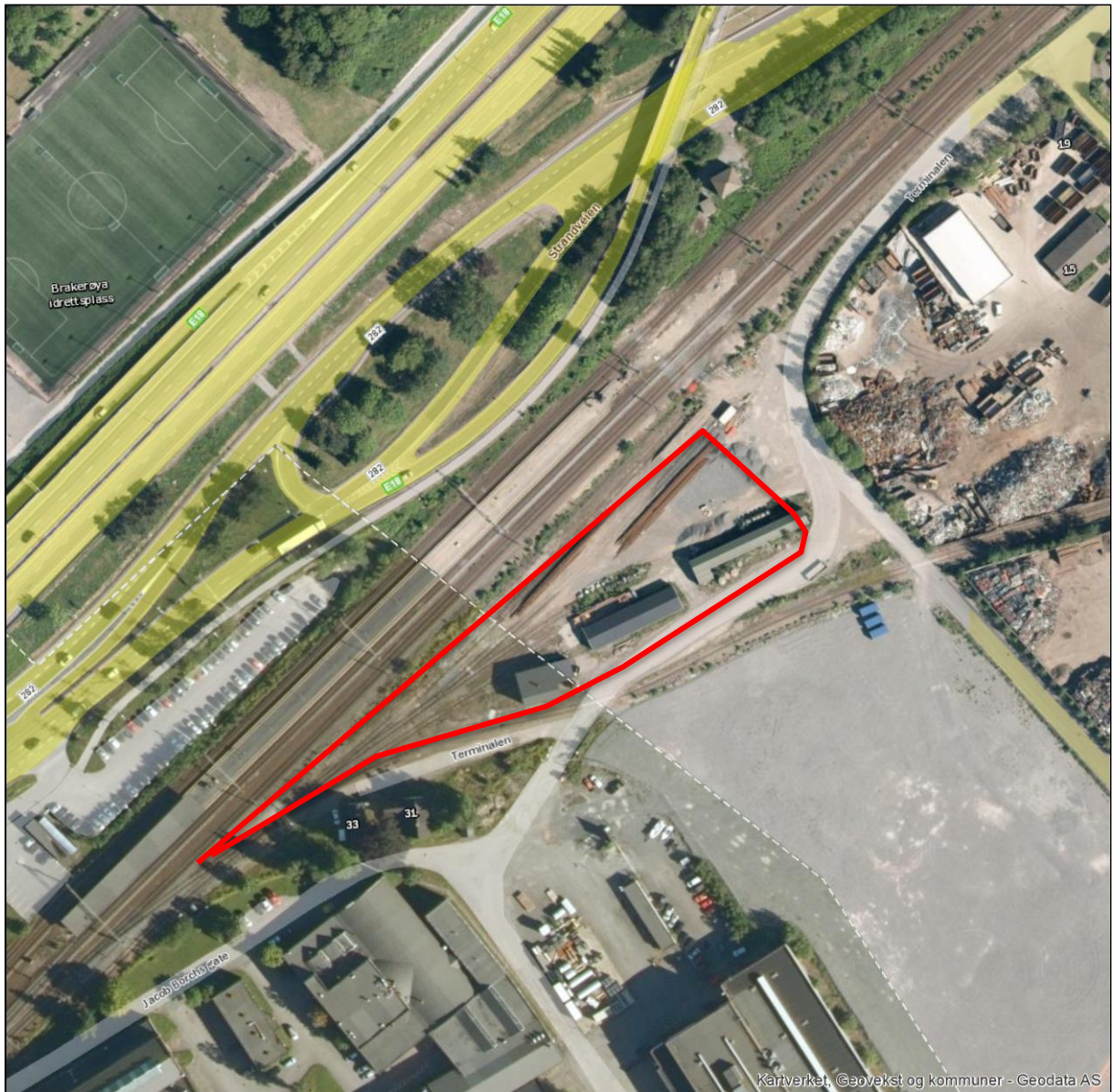
Figur 6-119: Eksisterende sidespor som brukes til arbeidsmaskiner
