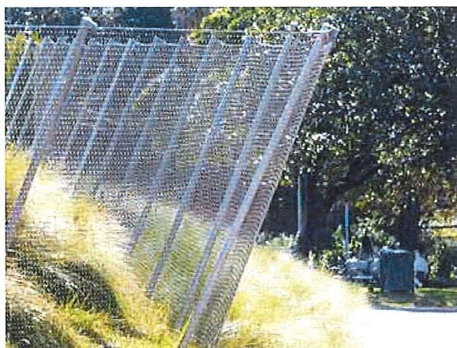
Sikkerhetsgjerde som hindrer adgang til helikopterlandingsplass
